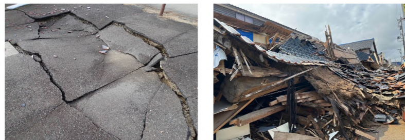
ひび割れやがれきで復旧のめどが立たない被災地の道路事情
